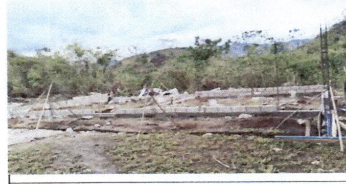
Foto 6: COLOCACION DE COLUMNAS DEL CORREDOR Y TORTA DE CONCRETO CON ALISADO.
