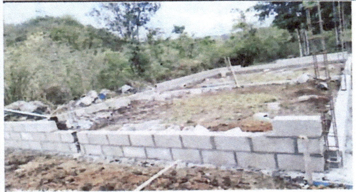
Foto 3: PARTE FRONTAL DEL MODULO 1, AULA 1, INTALACION DE COLUMNAS Y CULMINACION DE COLOCACION DE PARED
