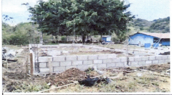
Foto 2: PARTE DE ATRÁS DEL AULA 1, SE COLOCARA Y SE CULMINARA LA PARED Y CON TECHO INCLUIDO
