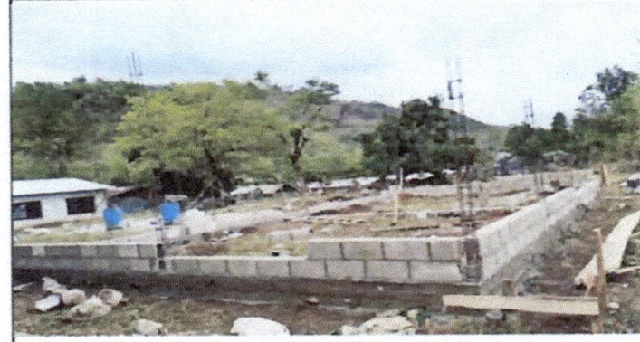
Foto 4: PARTE FRONTAL DEL MODULO 1, AULA 2, INTALACION DE COLUMNAS Y CULMINACION DE COLOCACION DE PARED
